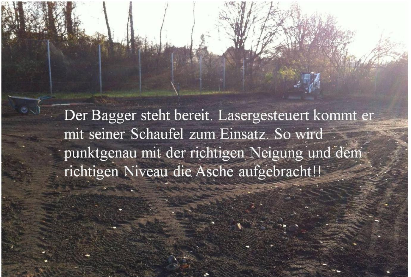
Der Bagger steht bereit. Lasergesteuert kommt er mit seiner Schaufel zum Einsatz. So wird punktgenau mit der richtigen Neigung und dem richtigen Niveau die Asche aufgebracht!!
